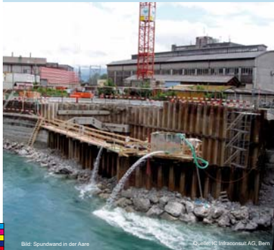
Bild: Spundwand in der Aare
