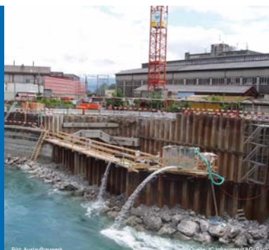
Bild: Auslaufbauwerk Quelle: IC Infraconsult AG, Bern
