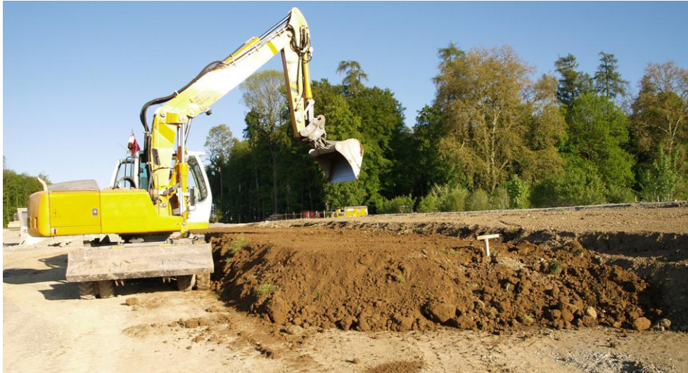
Fig. 37 > Reconstitution du sol par bandes successives en une seule étape
