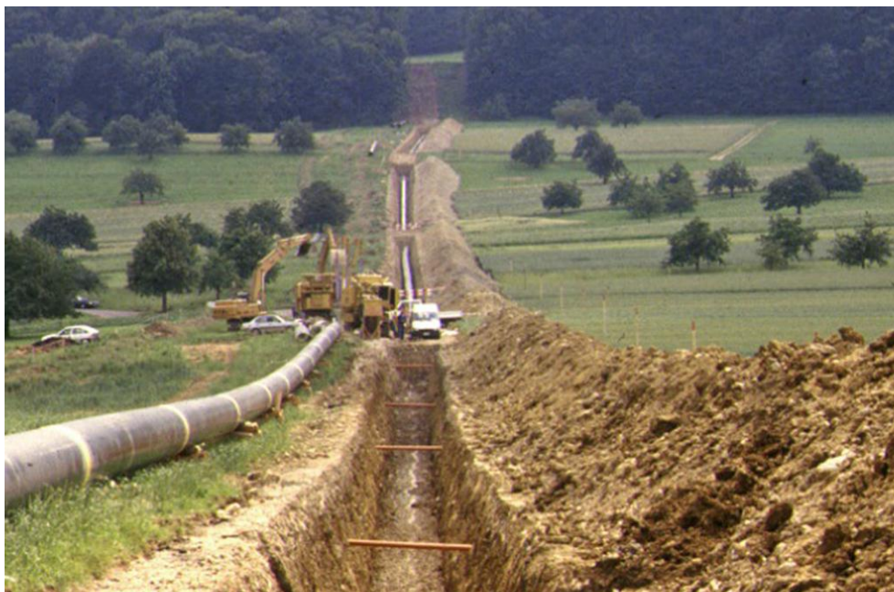
Fig. 2 > La fouille est excavée – Conduite de gaz Transitgas de Walbach (AG) à Däniken (SO) en 1994
